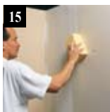
Влажная шлифовка исключает появление пыли
